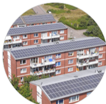
Solaranlage auf Zeilen
