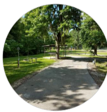
barrierefreier Weg durch glatten Asphalt
