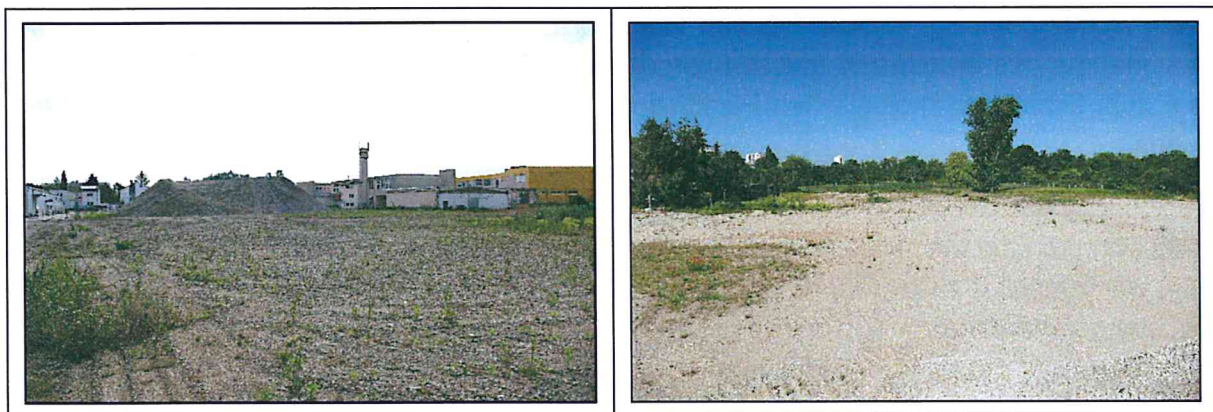
Abbildung 1: vegetationsarme Sand- und Kiesflächen des geplanten Baufelds
