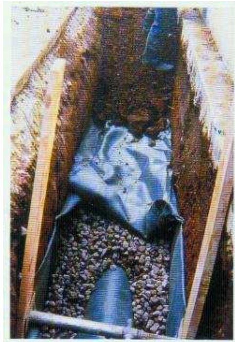
Abbildung 5: Ausführungsbeispiel Rigolenversickerung
