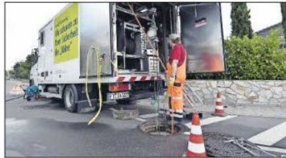
Vermessen, prüfen, dokumentieren (oben): Jürgen Meiling untersucht mit moderner Technik das Frankenthaler Kanalnetz. Rechts: Vom weißen Kastenwagen aus lässt Wilhelm Pirch Kameras in die „Unterwelt“ der Stadt und der Vororte – hier eine Kreuzung in Studernheim – hinab. FOTOS: BOLTE
