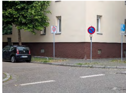
Abbildung 24: Nicht abgesenkter Bordstein im Schießgartenweg
