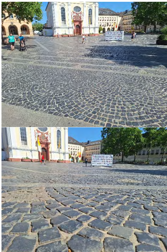
Abbildung 53: Oberflächenbelag auf dem Frankenthaler Rathausplatz
