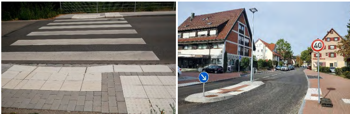
Abbildung 23: Beispiel für Doppelbord an gesicherter Querungsanlage; Beispiel für Doppelbord an ungesicherter Querungsanlage
