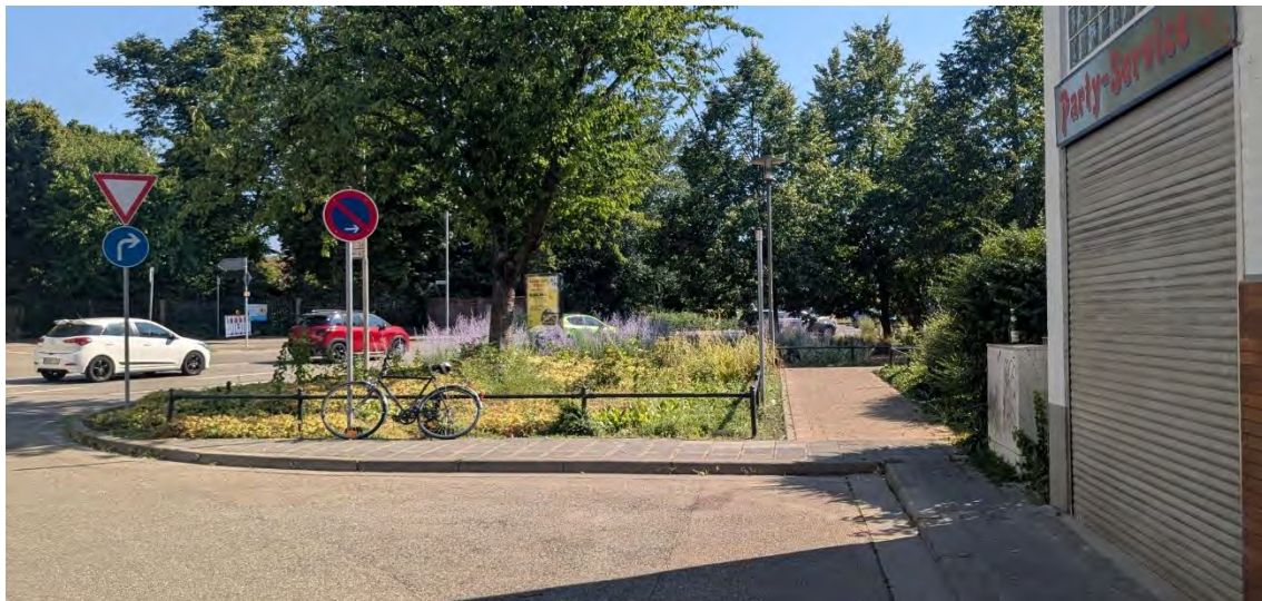
Abbildung 62: Fehlende Bordsteinabsenkung am Weg zur Lauergasse
